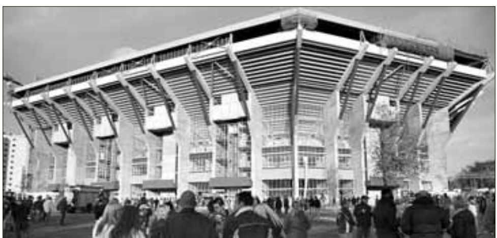
Am Kaiserslauterner WM-Stadion wird noch gebaut. Jetzt sind Risse aufgetaucht und die Arena ist vorläufig gesperrt worden. Archivbild: dpa
